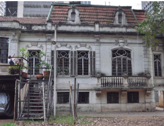
Lateral do casarão, mostrando deck metálico. Foto de Camila Raghi
